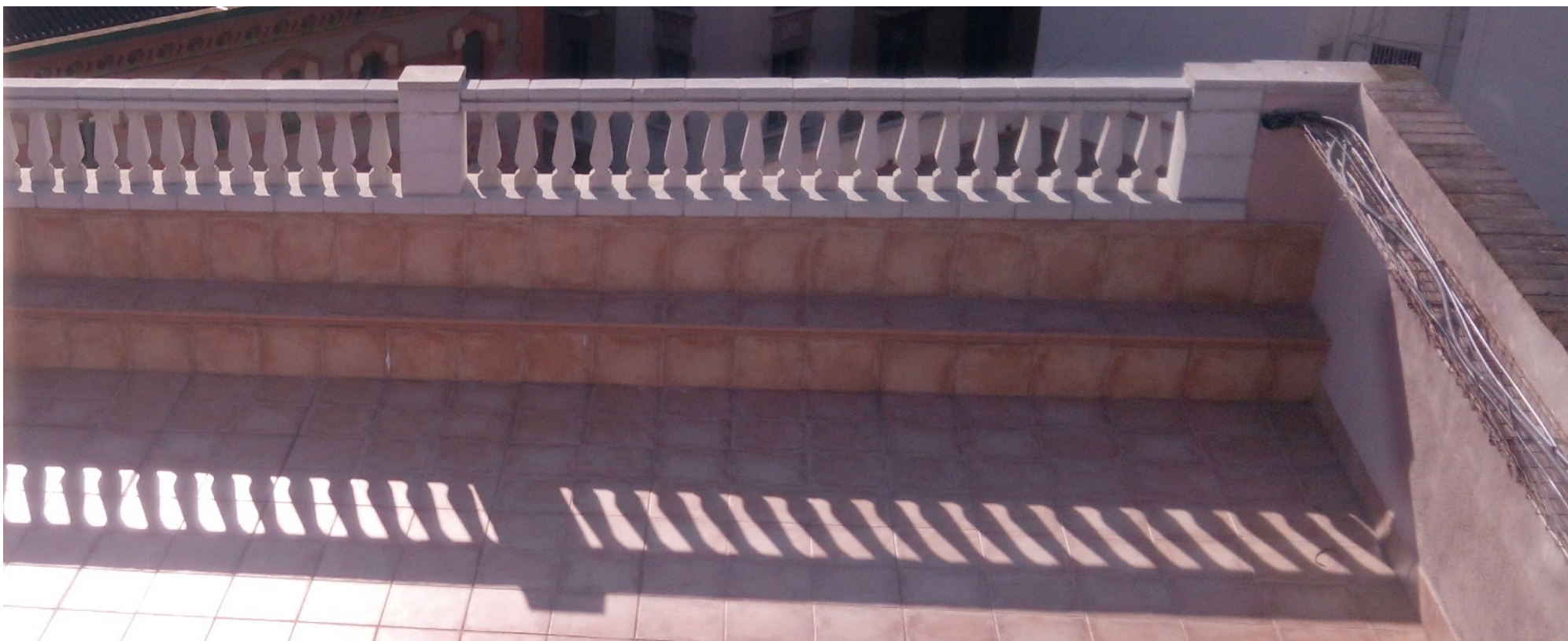
Banco perimetral en azotea de Barcelona.
