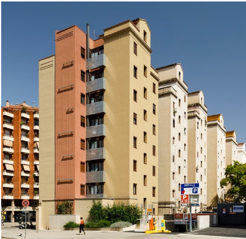
Integración de nidos en antepecho de cubierta en c/ Vilamarí 89/Av. de Roma 30. Barcelona
